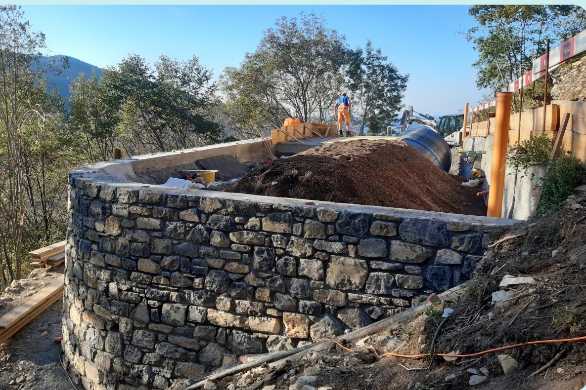
Figura 35. Lavori di costruzione del nuovo serbatoio dell'acqua potabile di Monte (terminati a fine ottobre 2022)
