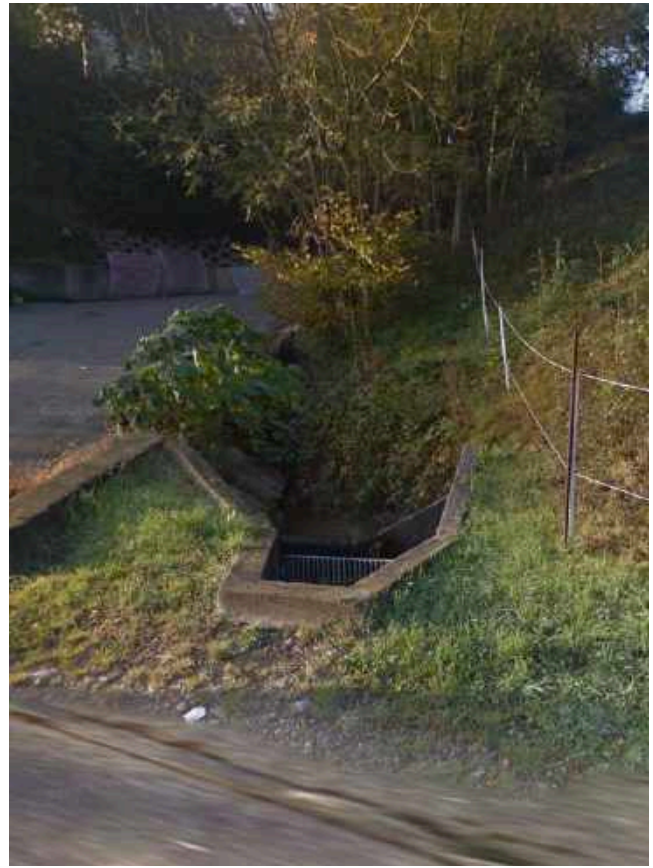
Immagine 26. Inizio del tratto intubato sotto la Via Piancorella.
