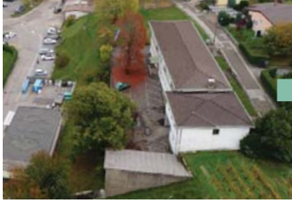
Tetto esistente in tegole marsigliesi.
