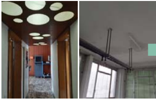
Controsoffitti e soffitti odierni.
