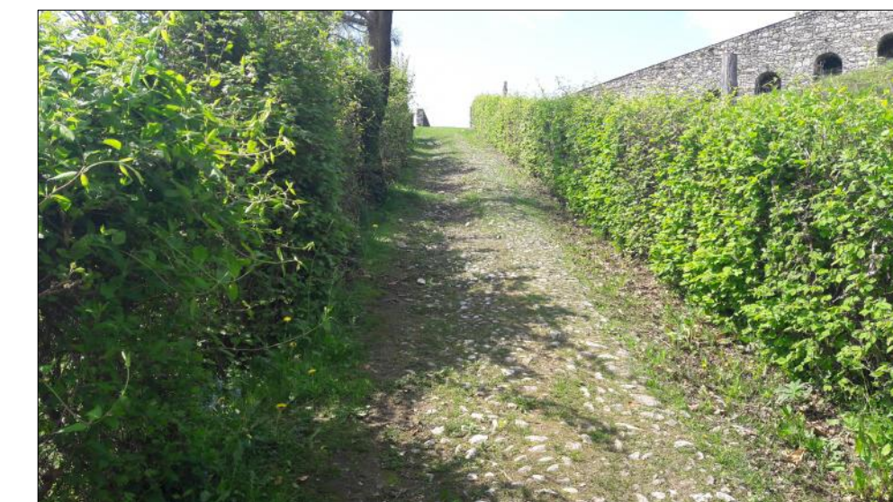
1b Tratta - Rifacimento- completo selciato tipologia come esistente
