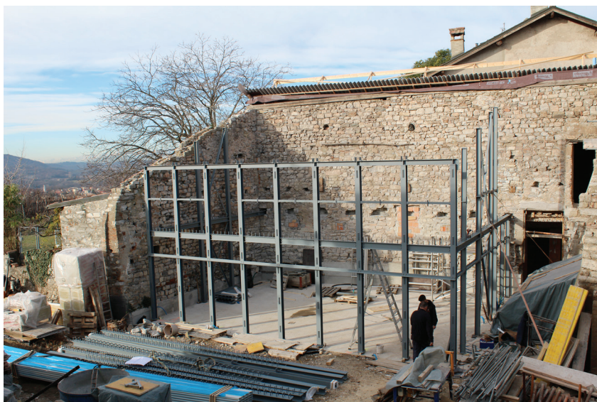
Struttura portante della futura sala multiuso
