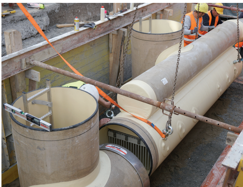
Scaricatore posato nello scavo in via Alle Zocche
