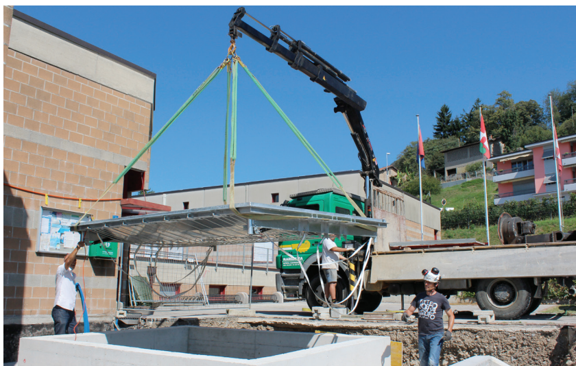
Posa nuovo coperchio della botola del silo del cippato
