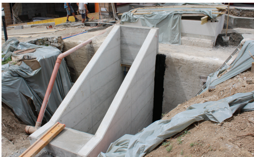
Formazione nuova scala esterna per l'accesso al silo del cippato
