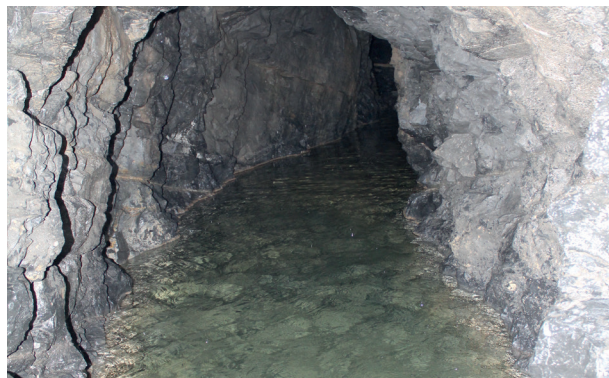
Laghetto di decantazione alla sorgente no.1
