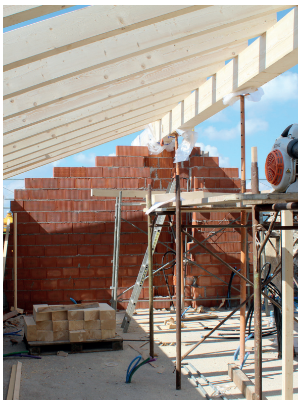
Nelle scorse settimane sono iniziati i lavori di posa della carpenteria del tetto.
