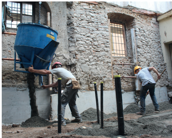
Una fase di lavoro durante la preparazione della platea nella parte adibita allo spazio del preasilo.
