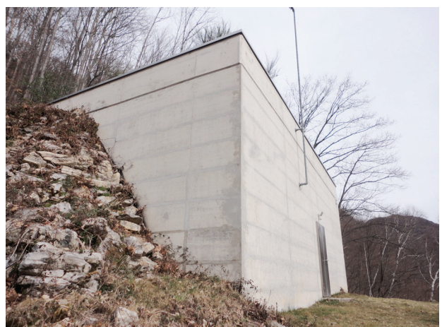
Casima: Il nuovo acquedotto realizzato sopra il paese.
