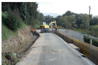
Fasi esecutive del nuovo muro di sostegno della tratta finale di via Marello
