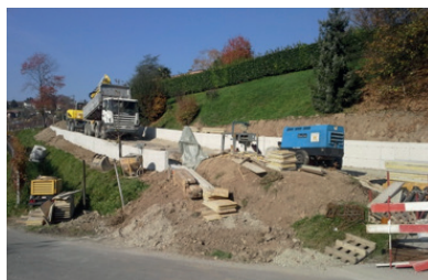
Posa nuovo collettore acque chiare e risanamento collettore acque luride in via Marello
