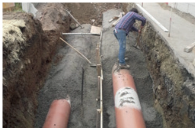
Posa nuovo collettore acque chiare e risanamento collettore acque luride in via Marello
