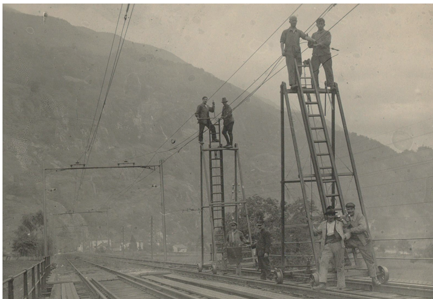
Elettrificazione della linea ferroviaria del Gottardo, tratta Faido-Lavorgo, 1923 ca, SBB Kreisdirektion II
