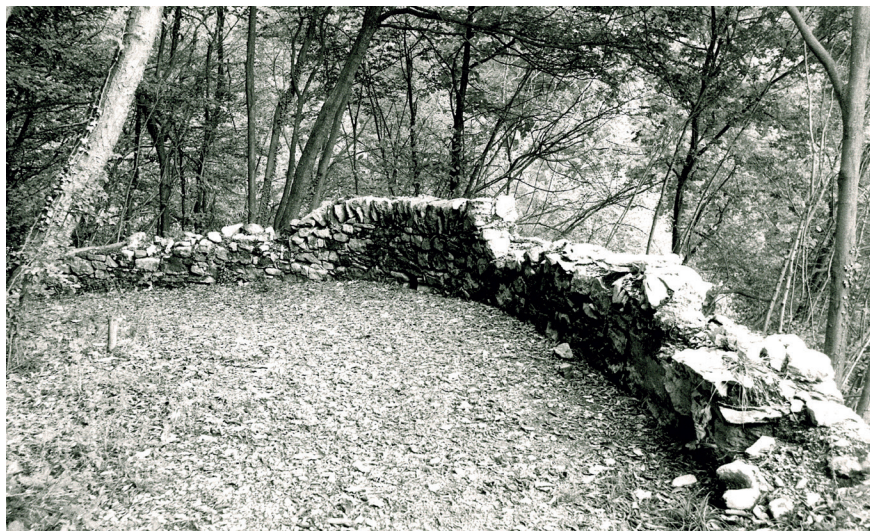
Resti della prima strada cantonale (parapetto ad accoltellato) (Archivio Foto Lombardo - Chiasso).
