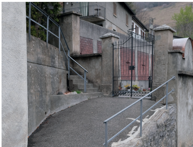
La rampa di accesso del cimitero.
