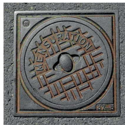
Punto fisso protetto da un chiusino. (Foto: Swisstopo)
