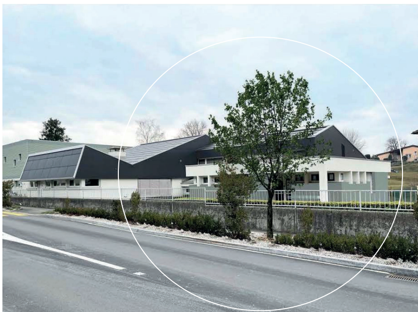
Simulazione dopo l'intervento energetico.
