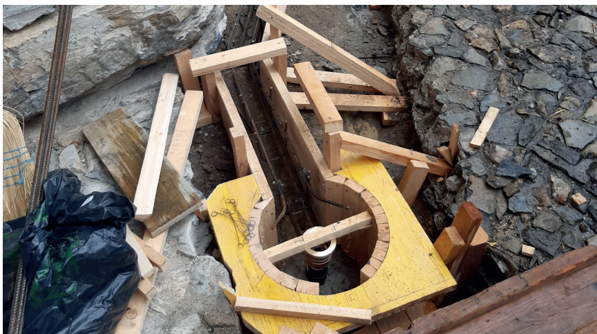
Foto sopra: dettaglio della canalina di scarico della nuova fontanella sul piazzale della chiesa. Foto sotto: realizzazione della nuova area di svago in zona Fontane.
