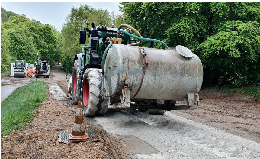
Fase di preparazione del sottofondo stradale.
