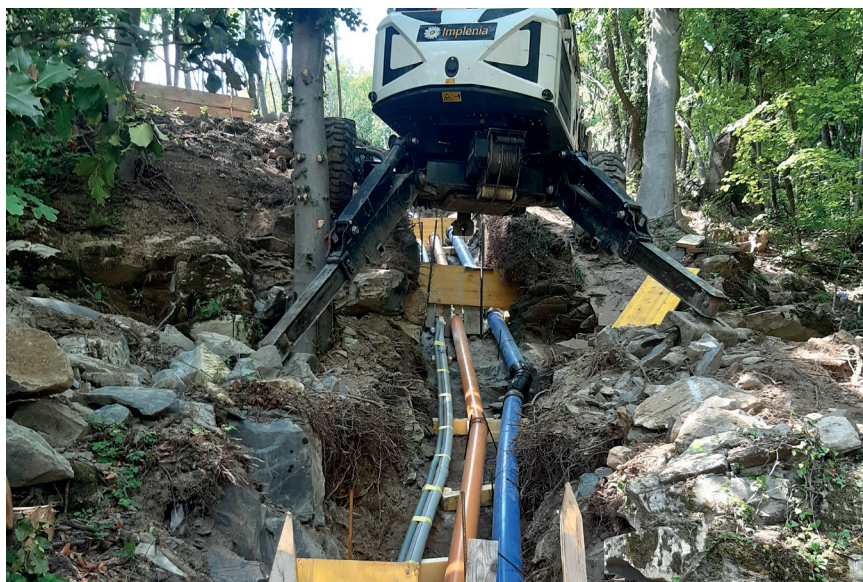
Posa delle condotte di alimentazione per il nuovo serbatoio.
