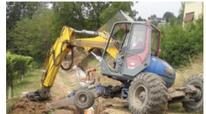
Posa collettore acque meteoriche in Via Pree
