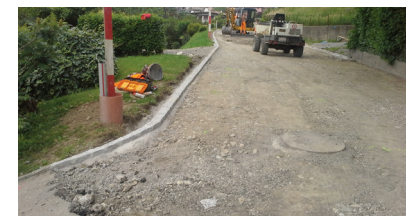
Rifacimento mocche e fondo stradale di Via Marello
