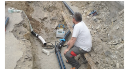
Sostituzione condotta acqua potabile in Via Marello
