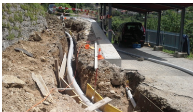
Posa infrastrutture AIL
