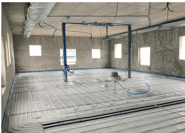
La posa delle serpentine nel pavimento al primo piano.
