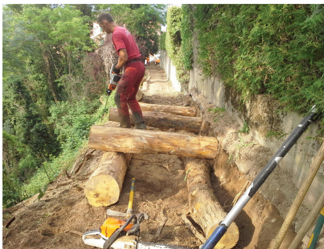
Durante i lavori di realizzazione del nuovo caminamento.
