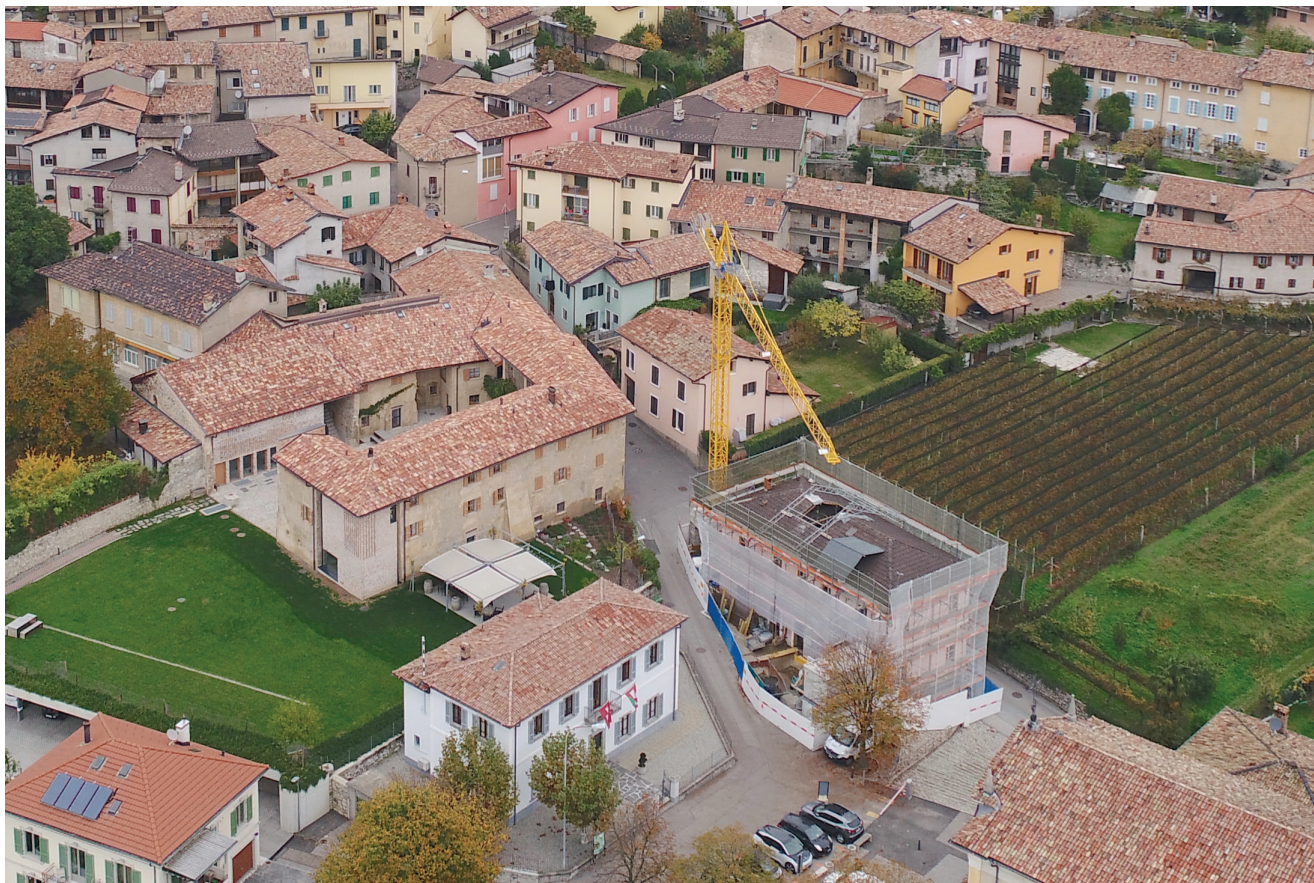
Veduta aerea del nucleo di Castel San Pietro con il cantiere in basso (Foto Oblivion Aerial).
