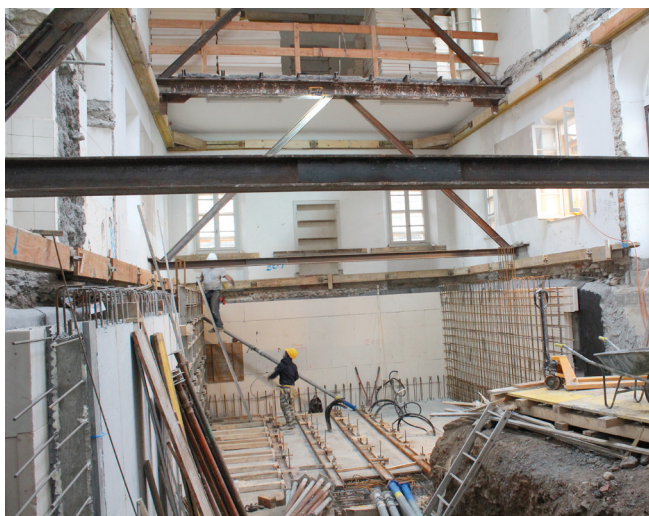
A destra e sinistra, platea e muri di sottomurazione.
