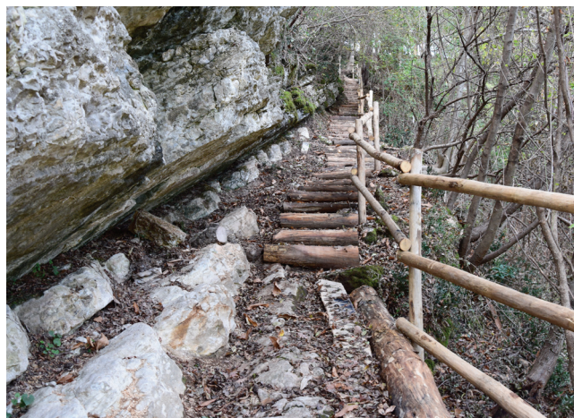
La ripida salita riqualificata subito dopo l'accesso dal Ponte di Castello.
