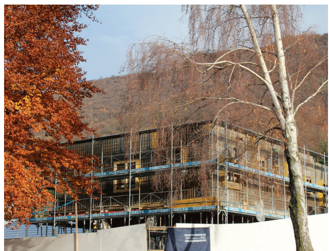
Vista sulla nuova ala (casseri - elevazione 1° piano).
