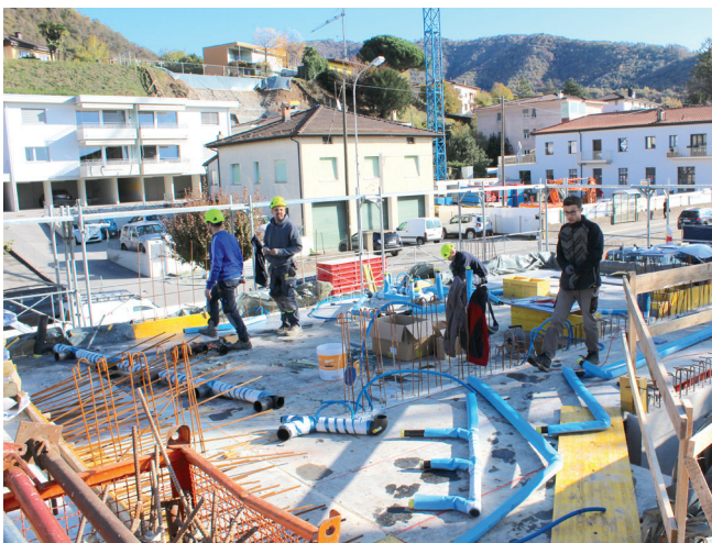
Installazioni sanitarie inserite nel getto della soletta.
