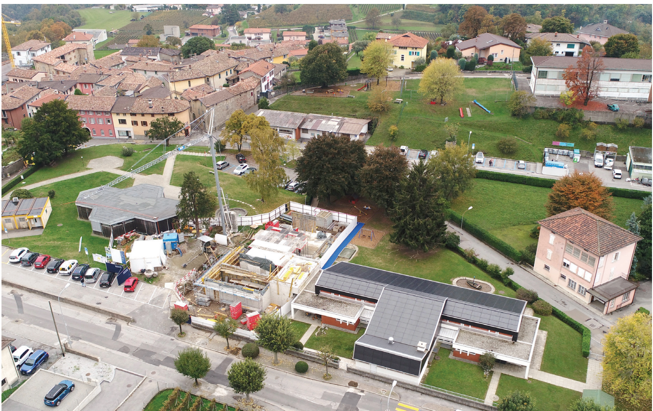
Una veduta aerea del nucleo di Castel San Pietro con il cantiere in primo piano (Foto Oblivion Aerial).
