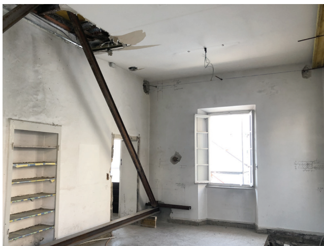
Gli stessi locali durante i lavori di consolidamento delle pareti perimetrali per consentire la demolizione delle solette e dei muri interni non portanti.
