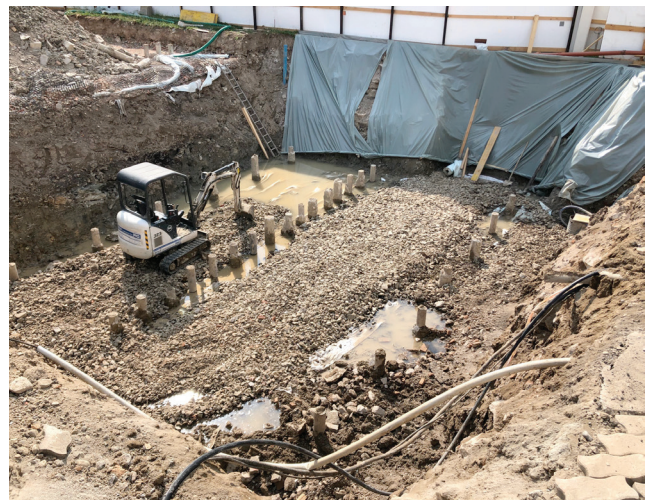
Esecuzione dello scavo del piano interrato e palificazione.
