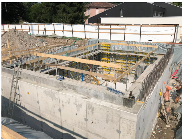
Esecuzione del piano interrato (pareti portanti).
