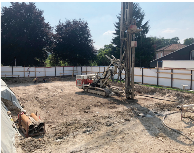
Esecuzione della palificazione.
