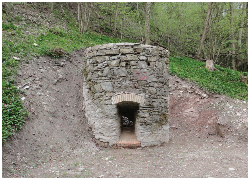
La calchèra di Via Pozzi-artisti; in alto, prima della ristrutturazione.
