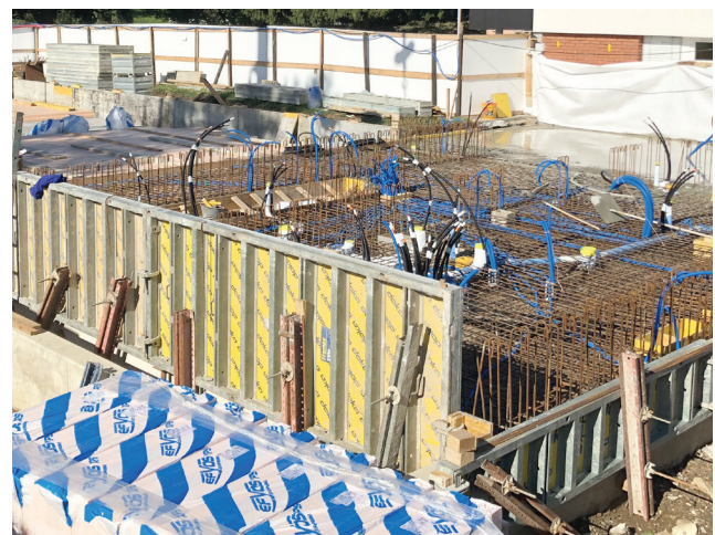
Esecuzione della soletta di copertura del piano interrato.
