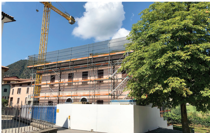
La preparazione del cantiere con la recinzione di limitazione.
