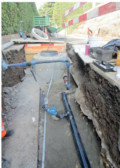
Uno scorcio dello scavo con la nuova condotta dell'acqua potabile.
