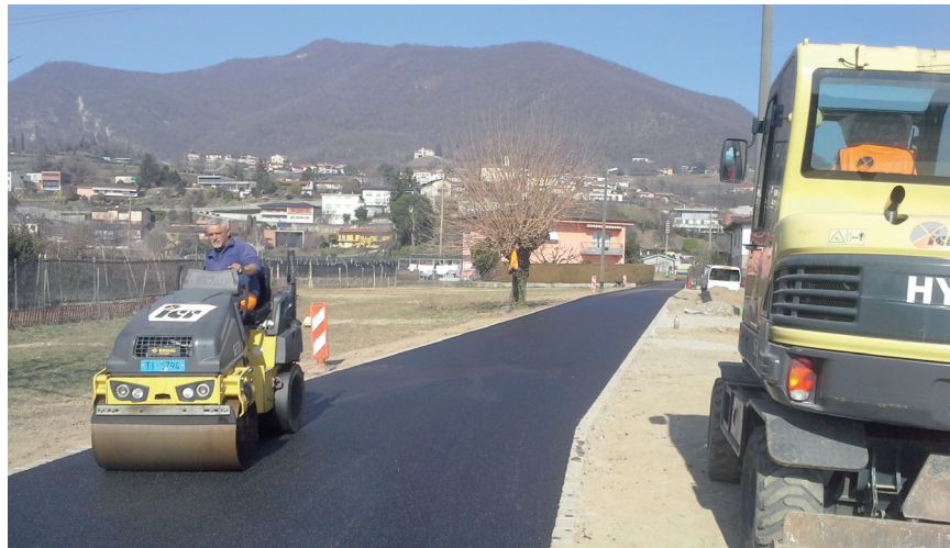
Fase di posa dell'asfalto su Via Nebione.
