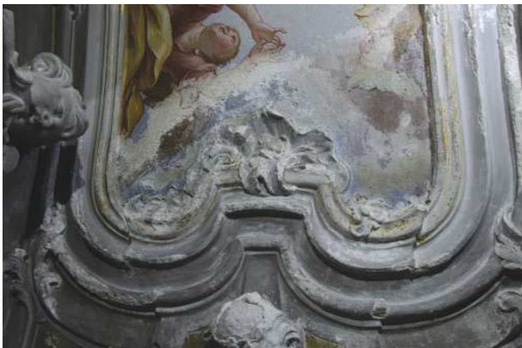
Cornice in stucco con doratura ed affresco
