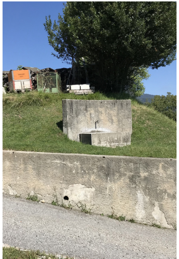
Img. 1: Situazione attuale della fontana ZEIC
