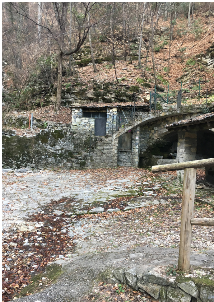
Img. 2: Situazione attuale del lavatoio
