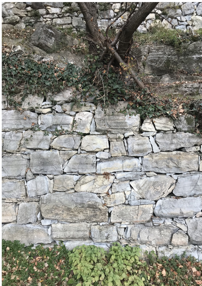
Img. 2: Muro a secco esistente a cui sarà fissata la panchina
