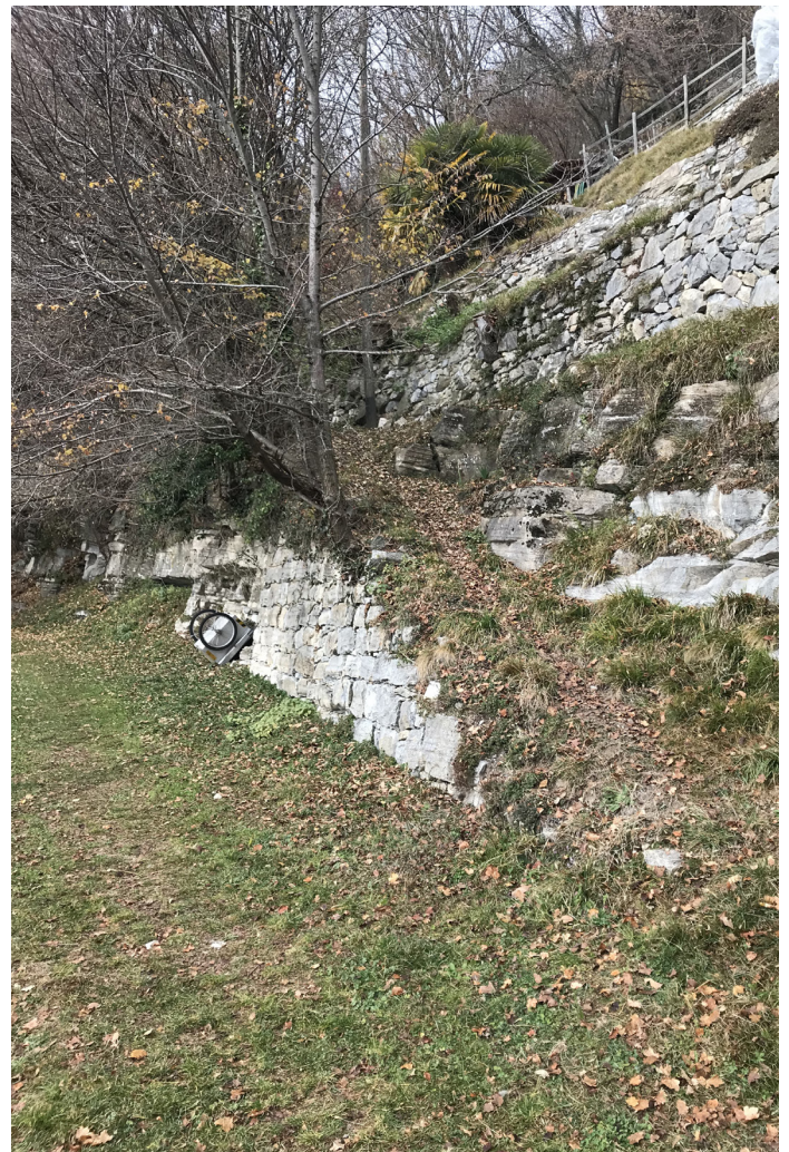
Img. 1: Situazione attuale dei muri a secco
