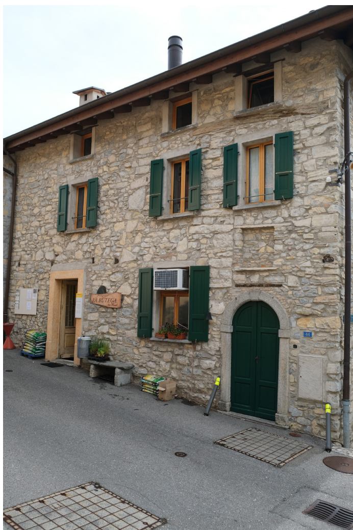
Img. 1: Situazione attuale della facciata della Bottega
