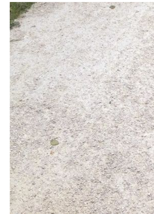
Fotografia pavimentazione in calcestre
