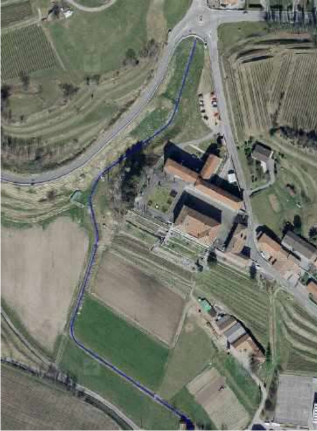
Immagine 29. Primo tratto a cielo aperto in località Vernora.
