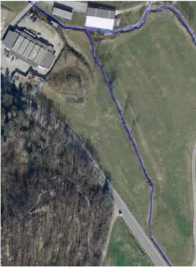
Immagine 27. Primo tratto a cielo aperto in località Vernora.
